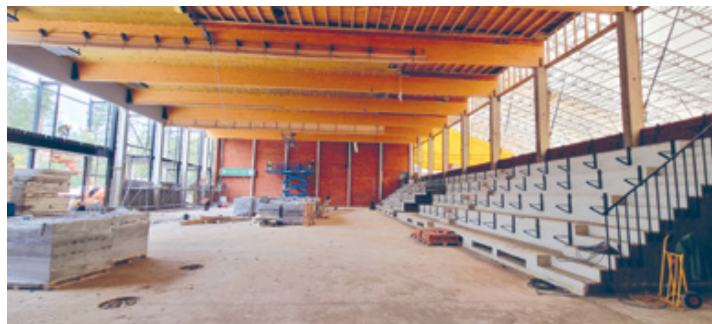
Palloiluhalli remontissa. Kuva syyskuun alussa, kun purkutyöt olivat loppusuoralla ja vähän uuttakin oli jo tehty.
